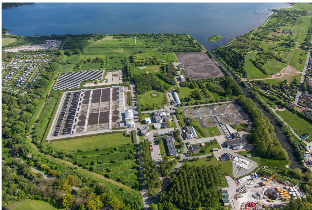
Renseanlæg Damhusåen. Foto: Hviid Photography
